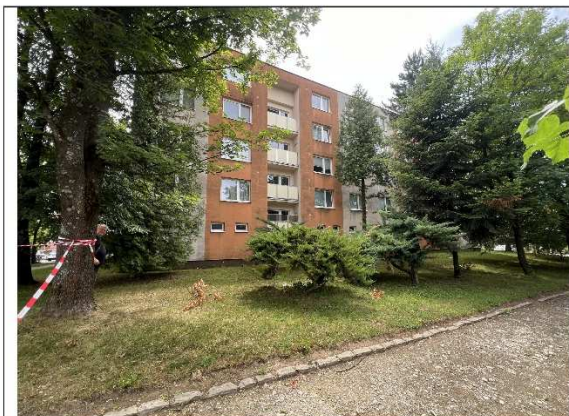
Bytový dom Ul. Palárikova 1625, pohľad S
