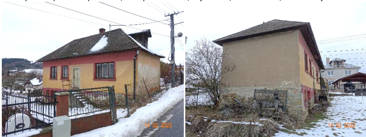
Severozápadný pohľad, vstup do kotolne, kotolňa na spodnom podlaží
