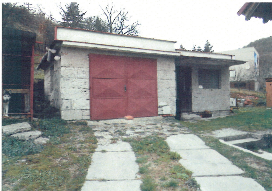
Garáž na parc.č. 240, k.ú. Orovnica
