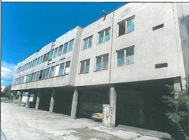
Výrobná hala, p. č. 5692/4, k. ú. Lučenec, sociálne zázemie
