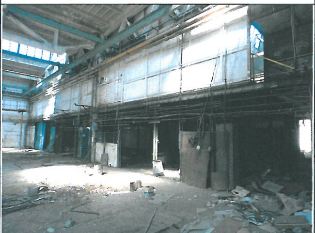
Výrobná hala, p. č. 5692/62, k. ú. Lučenec, sociálne zázemie
