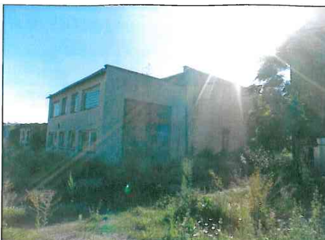
Výr. hala s. č.4262, p. č. 151/19, k. ú. Rimavská Sobota
