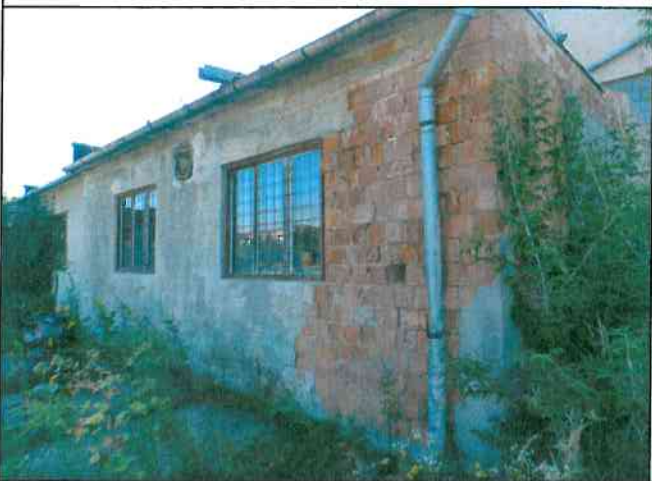
Výr. hala s. č.4262, p. č. 151/19, k. ú. Rimavská Sobota, prístavba
